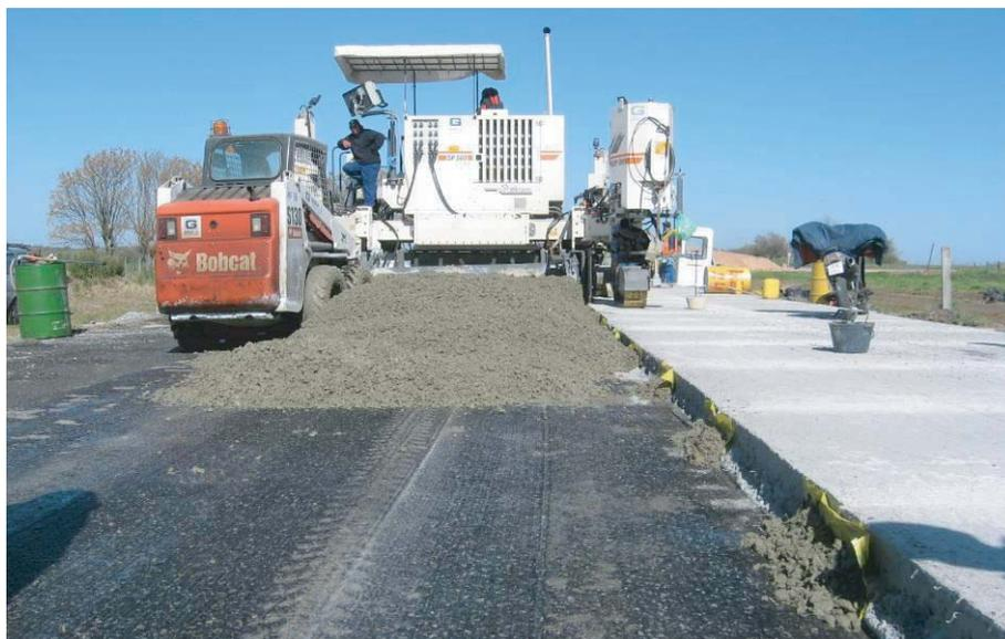
**Fig. 7.** Pavimentación de la segunda media calzada. Se coloca film en canto de juntas.
