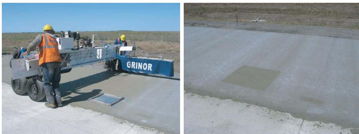
**Fig. 10.** Aplicación del compuesto líquido con carro de curado, y control de la dosis efectiva.
