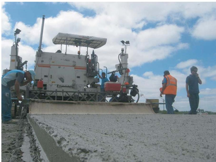
**Fig. 8.** Detalle de la superficie recién terminada y texturada con arpillera húmeda.
