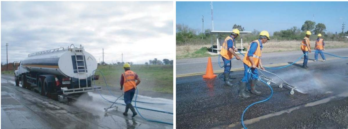
**Fig. 4.** Limpieza con hidrolavado (cisterna de 22 m<sup>3</sup> con dos bombas independientes).
