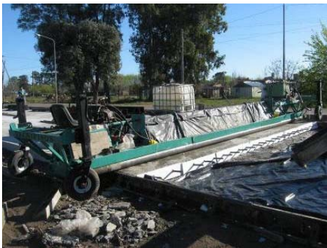
Fig 1. Izq. Pavimentación en RP N° 21, con regla de rodillos. Der. Vista correspondiente al 9/9/09.
