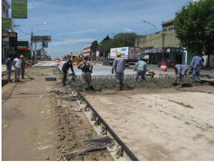
Fig. 2. Izq. Pavimentación en RP N° 4, con regla vibratoria. Der. Vista correspondiente al 22/10/09.
