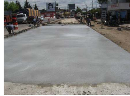
Fig. 2. Izq. Pavimentación en RP N° 4, con regla vibratoria. Der. Vista correspondiente al 22/10/09.
